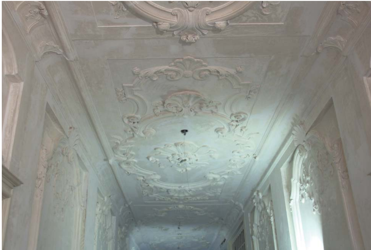
Het stucwerk in de lange hal is vrijgelegd en gerepareerd. Klaar om te schilderen
