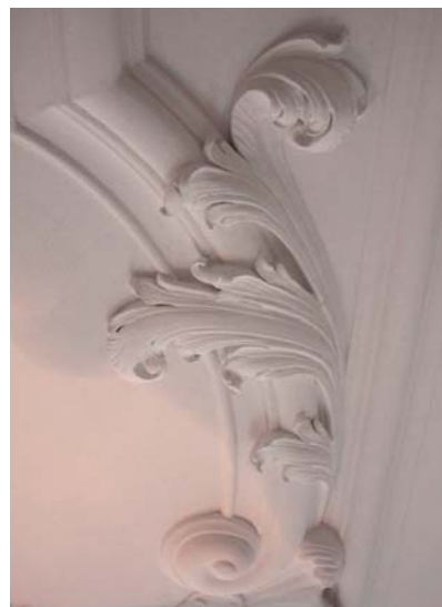
Enmaal ontdaan van oude kalklagen en opnieuw geschilderd zijn de detailleringen weer goed zichtbaar
