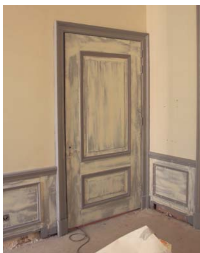
Voordat Frank Buijtenorp er met lijnolieverf aan de slag gaat, is het houtwerk gerepareerd en geplamuurd
